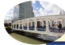
区民有文化財に指定された、白い鉄骨造が印象的な豊海橋。
