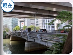
昭和32年に完成したゲルバー桁橋。
