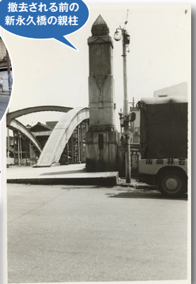
新永久橋 (昭和43年)
