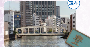
震災後の昭和2年に竣工した橋が現役。
