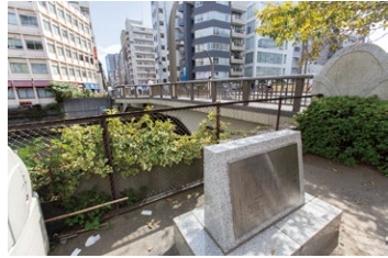
新亀島橋の初代は明治15年の架橋。平成7年に耐震護岸整備のため現在の3代目が誕生しました。
