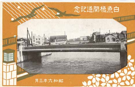
白魚橋開通記念—架橋後新橋— 鴻池組(昭和6年)
